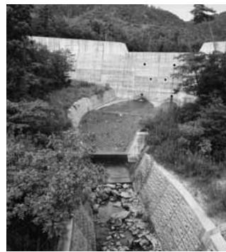
▲三谷川砂防ダム
