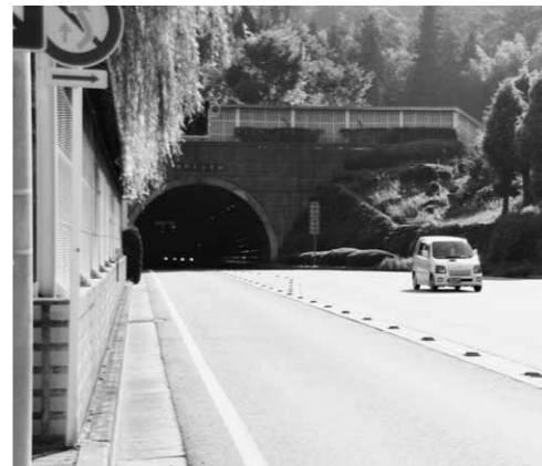
▲平成33年に無料開放予定の熊野トンネル
