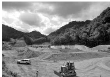
◀深原地区の町有地造成工事（8月現在）
