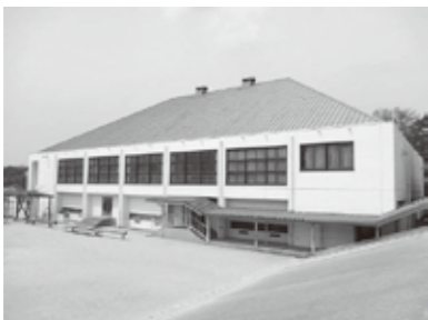
耐震補強工事を行う 熊野第四小学校体育館
