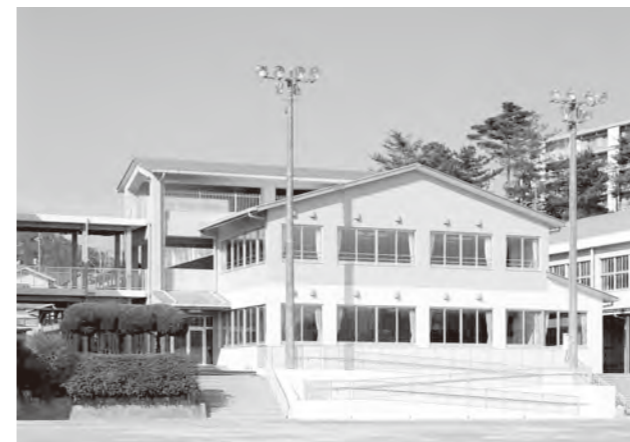
▲建替工事を行った第三小北校舎
