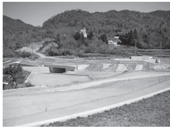
▲熊野黒瀬トンネル付近の工事（萩原地区）
