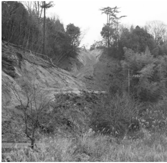
整備中の千ヶ峠林道（ゆるぎ観音側）
