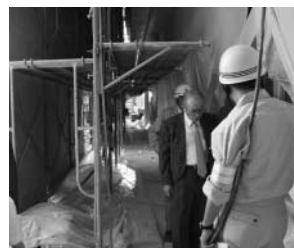
10月4日 ◀耐震補強の状況を確認
