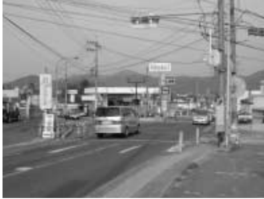
改良工事が進む川角交差点
