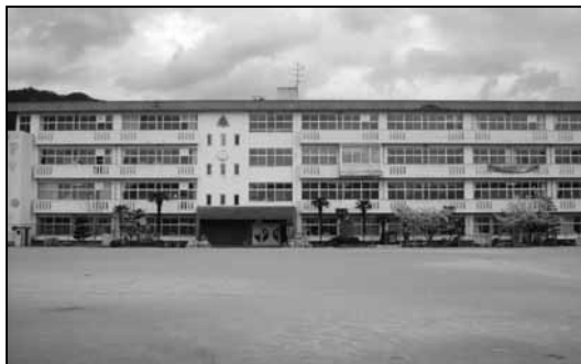
改修のための設計を行う第一小学校中校舎
