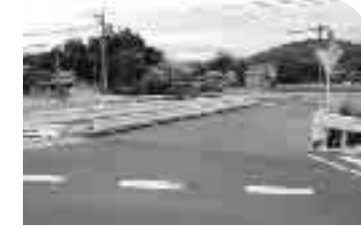
川角大橋架替工事の様子
