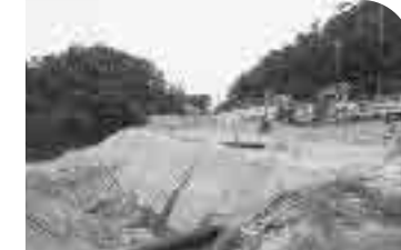
焼却炉解体後の跡地整備が進む
