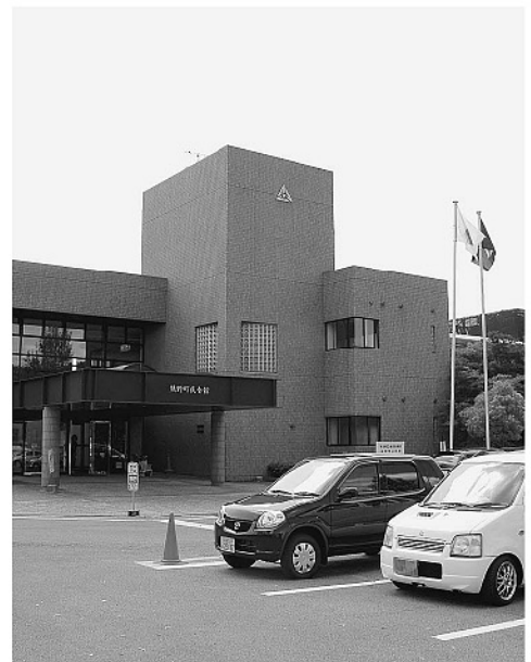
●一部老朽化が見られる町民会館
