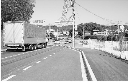
●バスベイが設けられ、一部改良された道垣内交差点だが…
